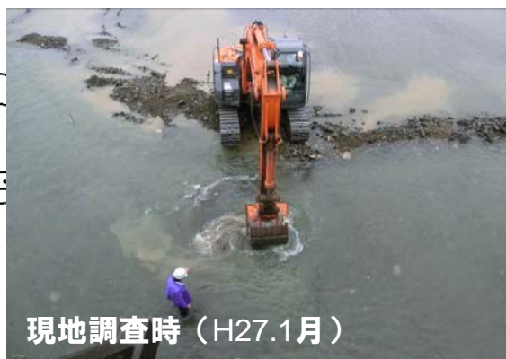
現場調査時 (H27.1月) 重機により試掘し、護床工の有無を確認
