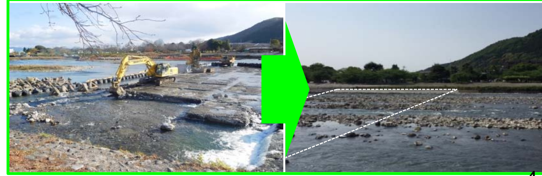
6号井堰撤去 (H29完了)
