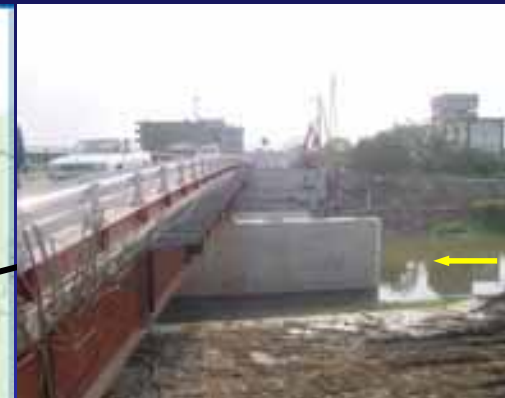
橋梁架替(杉橋)
