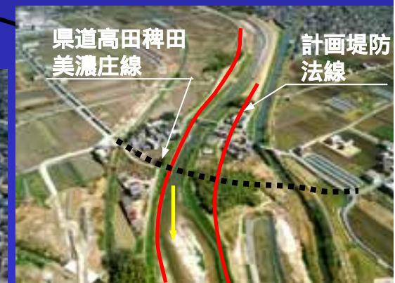
引き堤・橋梁架替(稗田地区)
