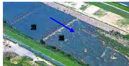
写真3.4 河川浄化施設 (長吉長原地区)
