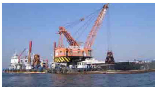
河口部土砂浚渫
