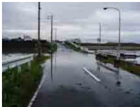
写真 1.14 天理・王寺線 (川西町付近) (平成 19 年 7 月洪水)
