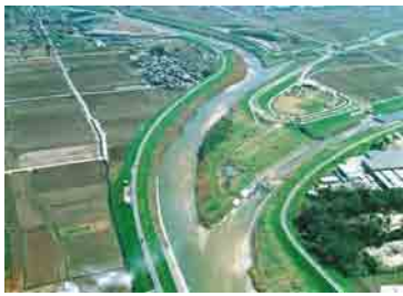
写真 1.25 中流部の状況
