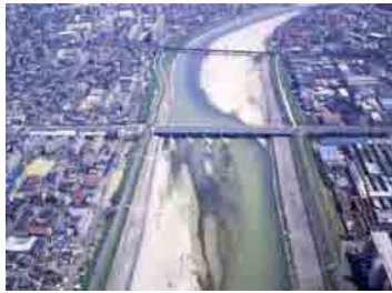
写真 1.31 下流部の状況
