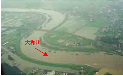
写真 1.12 河合町付近 (平成 11 年 8 月洪水)
