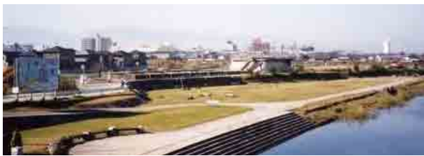
写真 2.15 初瀬川金屋河川公園
