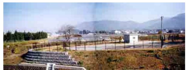
写真 2.14 三輪川浄化施設
