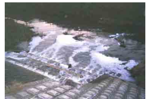
写真 2.13 飛鳥川に排水される濁水
