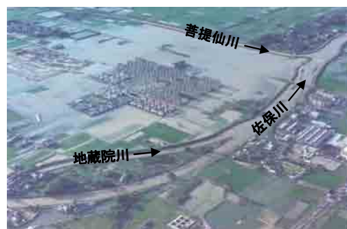
写真4.11 内水被害（佐保川5.2k付近）
