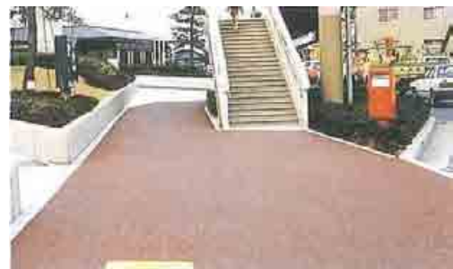
写真 1.21 透水性舗装(斑鳩町役場前)
