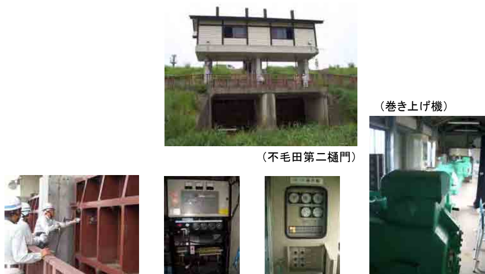
写真 4.9 機械設備の点検状況
