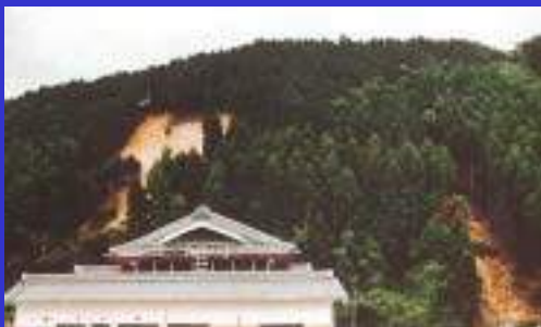
人家裏山の斜面崩壊発生当時
