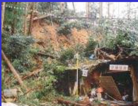
人家裏山の斜面崩壊発生当時
