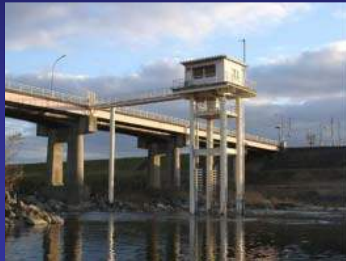
河内橋水質自動監視装置
