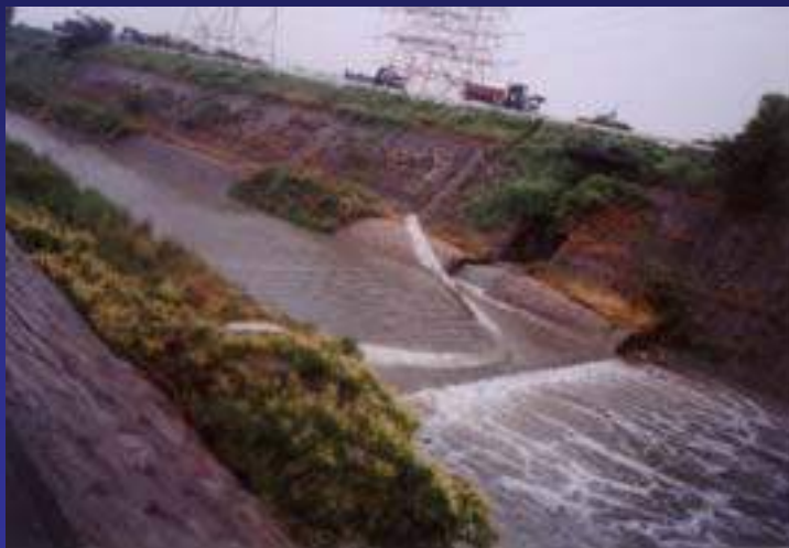
オイルマットでの対策状況（東除川合流点）
