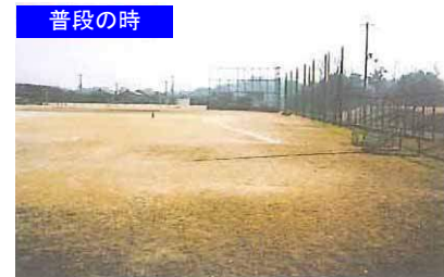
写真 1.22 雨水貯留浸透施設(広陵町立真美ヶ丘中学校)
