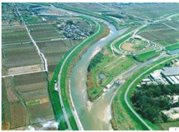
写真 1.25 中流部の状況
