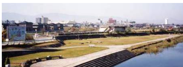
写真 2.16 初瀬川金屋河川公園
