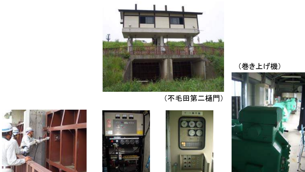
写真 4.11 機械設備の点検状況
