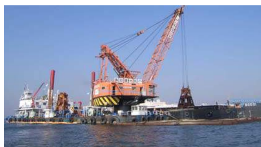
河口部河道掘削
