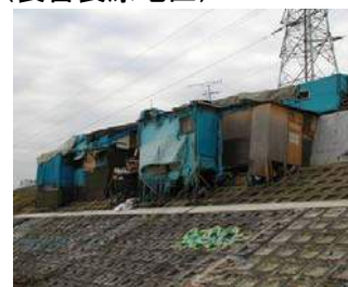
写真3.5 不法占用の状況
