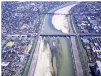
写真 1.31 下流部の状況
