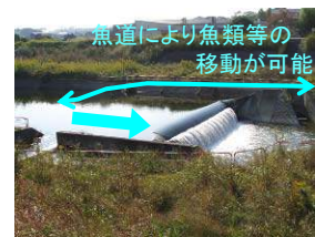
写真4.3 曾我川取水堰の魚道
