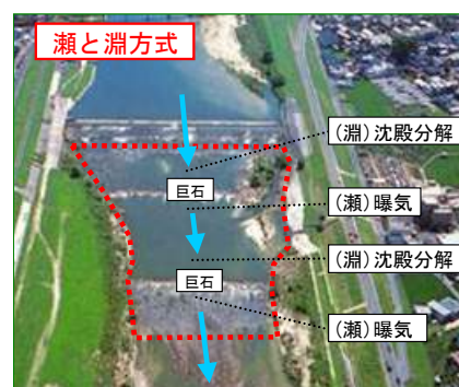
図 1.22 瀬と淵浄化施設
