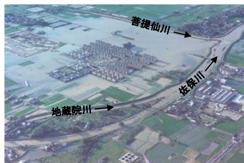
写真4.13 内水被害（佐保川5.2k付近）
