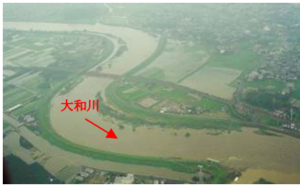
写真 1.12 河合町付近 (平成 11 年 8 月洪水)
