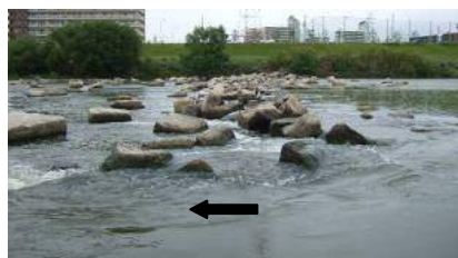
写真4.5 巨石投入による瀬・淵の再生事例 (大和川12.0k下流浄化施設)
