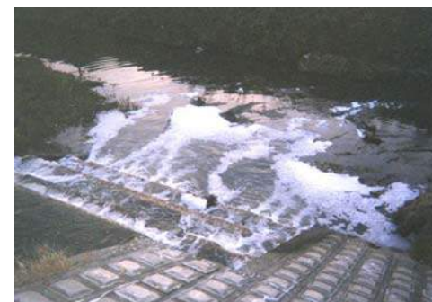
写真 2.14 飛鳥川に排水される濁水
