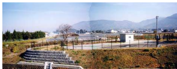
写真 2.15 三輪川浄化施設
