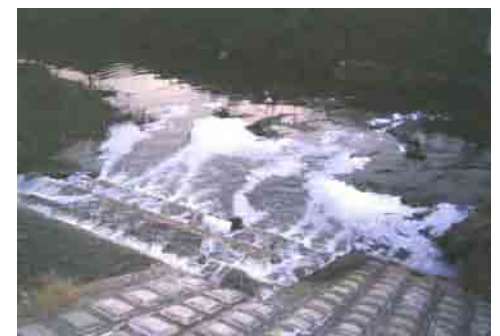
写真 2.13 飛鳥川に排水される濁水
