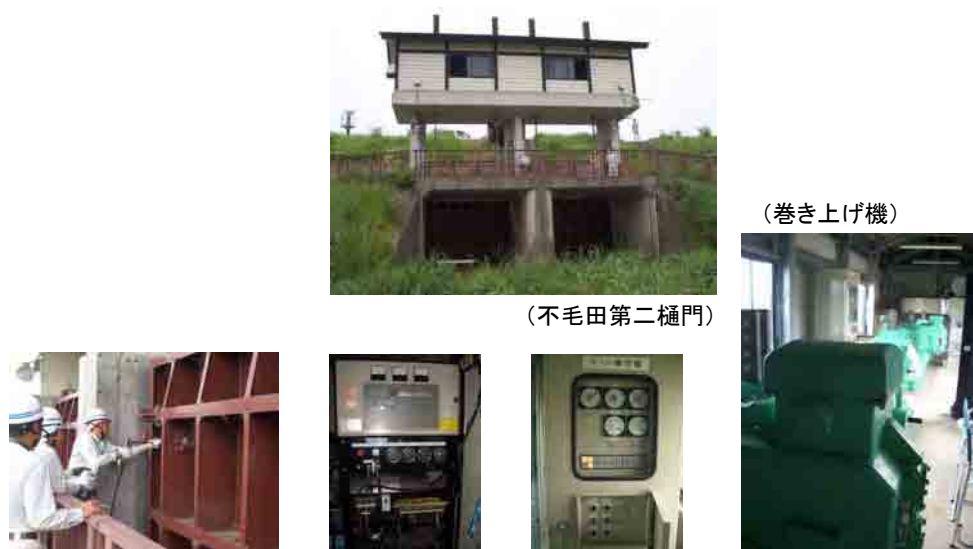
写真 4.11 機械設備の点検状況
