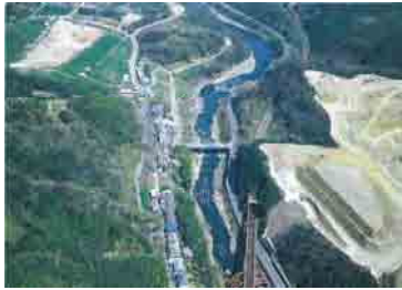
写真 1.28 亀の瀬の状況
