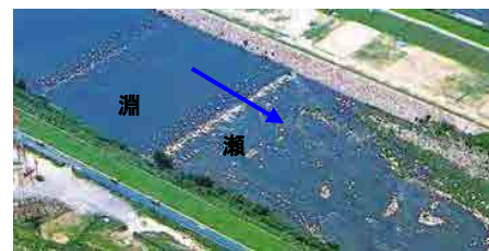
写真3.4 河川浄化施設 (長吉長原地区)
