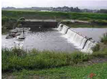
写真 2.1 堰による落差 (須原井堰、佐保川 1.3k)
