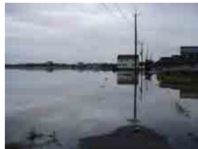
写真 1.16 川西町付近 (曾我川右岸堤内地) (平成 19 年 7 月洪水)
