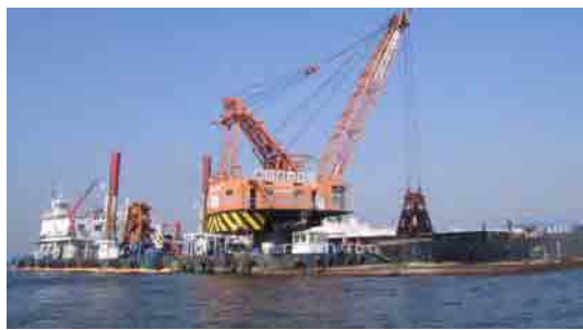
河口部土砂浚渫
