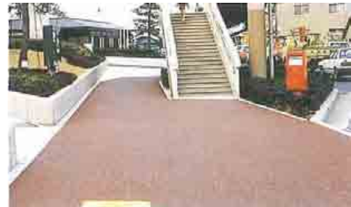
写真 1.21 透水性舗装(斑鳩町役場前)
