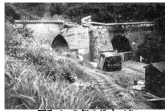
昭和 6~7 年の地すべり (国鉄関西本線の崩壊)
