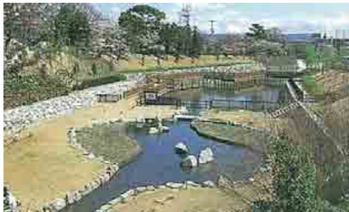
写真 1.18 ため池治水利用施設
