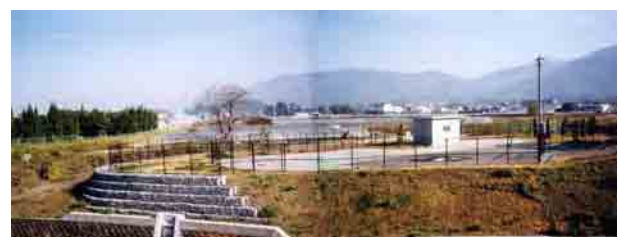
写真 2.14 三輪川浄化施設
