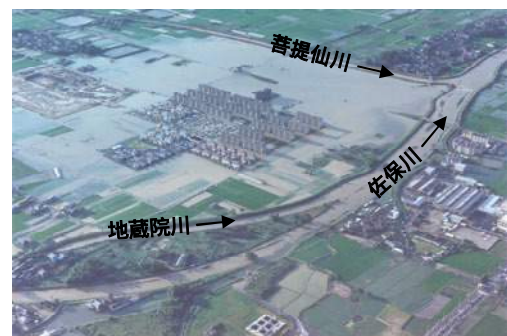
写真4.11 内水被害（佐保川5.2k付近）
