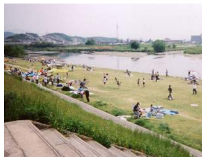
写真 2.5 高水敷の利用状況
