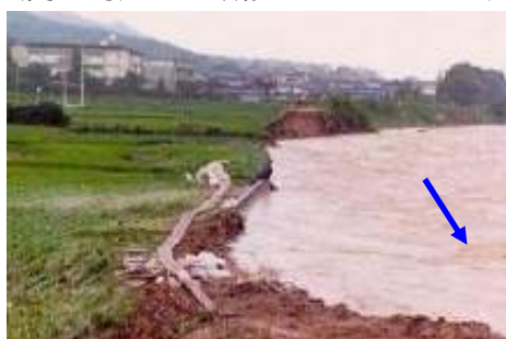
写真 2.18 昭和 57 年 8 月洪水 (石川 昭和橋上流右岸)
