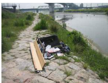
国道 26 号大和川大橋付近(右岸)
