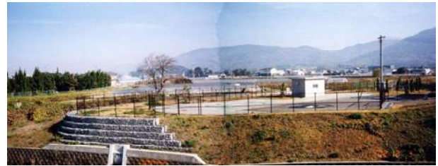
写真 2.11 三輪川浄化施設
