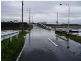
写真 1.14 天理・王寺線 (川西町付近) (平成 19 年 7 月洪水)
