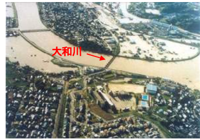
写真 1.9 王寺町付近 (昭和 57 年 8 月洪水)
