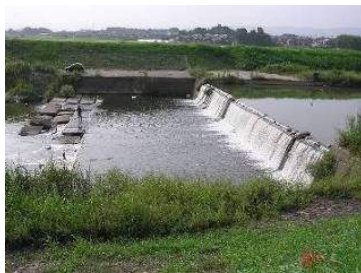
写真 2.1 堰による落差 (須原井堰、佐保川 1.3k)
