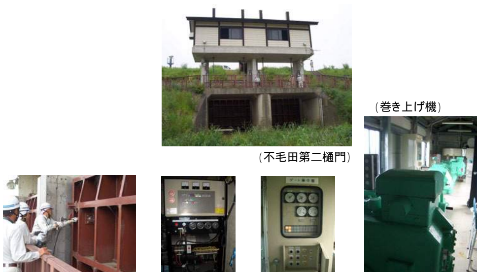
写真 4.9 機械設備の点検状況
