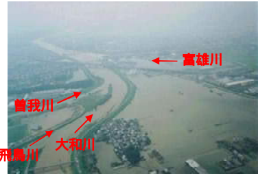
写真 1.13 安堵町・河合町・斑鳩町付近 (平成 11 年 8 月洪水)
