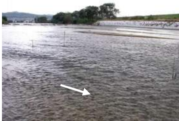
写真2.3 瀬と淵浄化施設により再生された瀬 (大和川15.2k付近)
