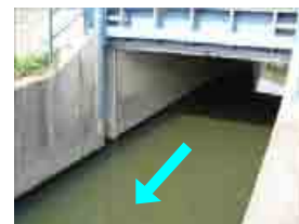
写真4.4 落差がなく移動が可能な水路 (佐保川2.3k付近 美濃川樋門)
