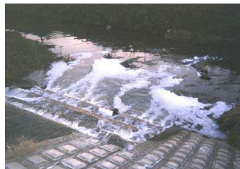
写真 2.8 飛鳥川に排水される濁水
