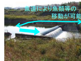
写真4.3 曾我川取水堰の魚道
