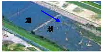
写真3.4 河川浄化施設 (長吉長原地区)
