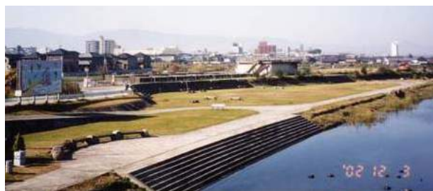
写真 2.11 初瀬川金屋河川公園
