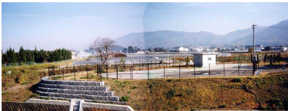
写真 2.9 三輪川浄化施設
