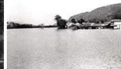
昭和 6～7 年の地すべり（大和川上流の浸水）
