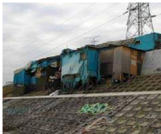
写真3.6 不法占用の状況
