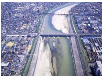
写真 1.32 下流部の状況
