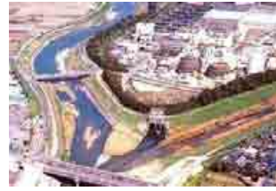
写真3.5 奈良県浄化センター
