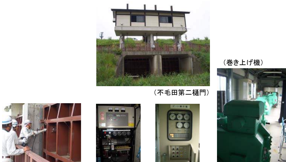
写真 4.10 機械設備の点検状況
