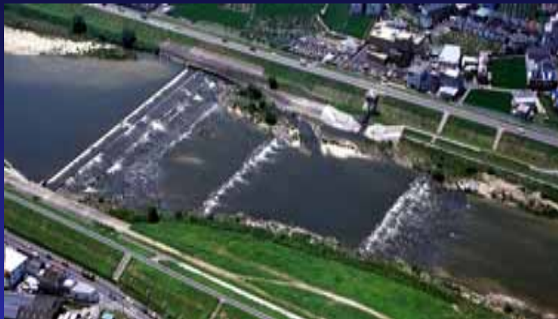
河川浄化施設(瀬と淵浄化施設)
