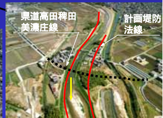
引き堤・橋梁架替(稗田地区)
