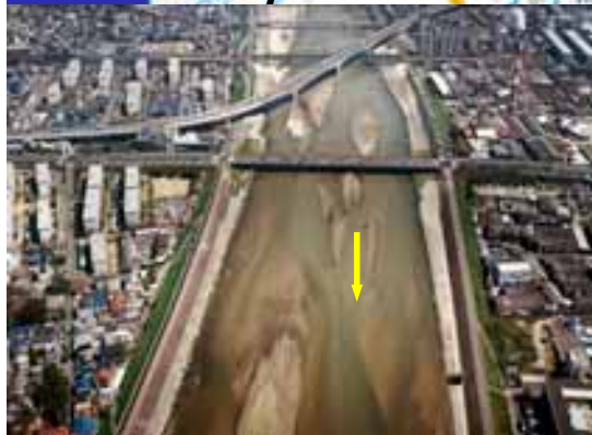
河床掘削(河口部)
