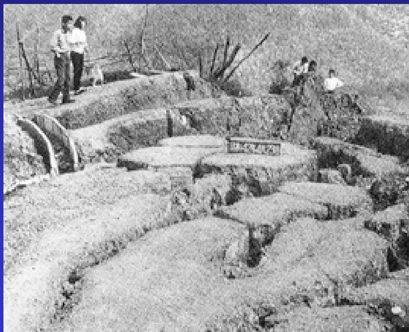
昭和42年 畑地の亀裂・陥没
