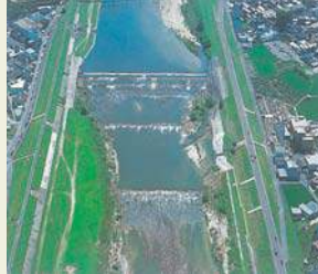
□柏原地区浄化施設「瀬と淵浄化方式」
