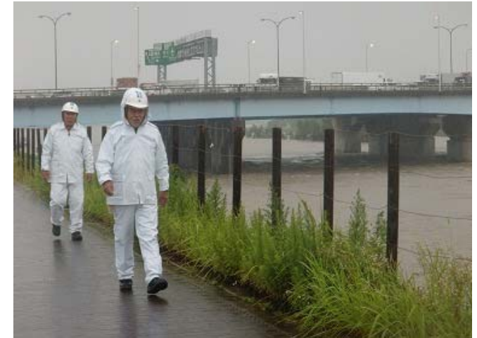
大和川右岸(平野区長吉川辺2丁目地先)堤防巡視状況
