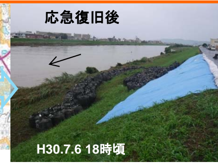
堤防法崩れ<大和川左岸7.2k(堺市北区)>
