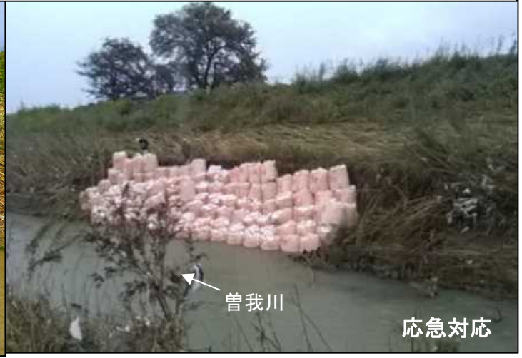
曾我川右岸1.8k 低水護岸損壊 L=160m
