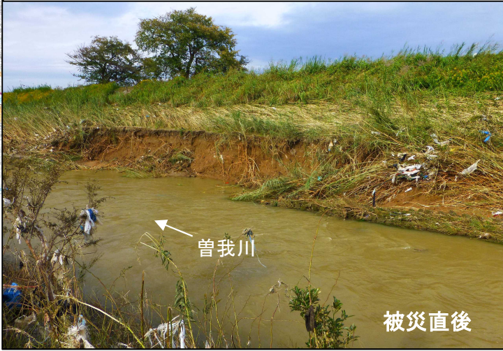
曾我川右岸1.8k 低水護岸損壊 L=160m
