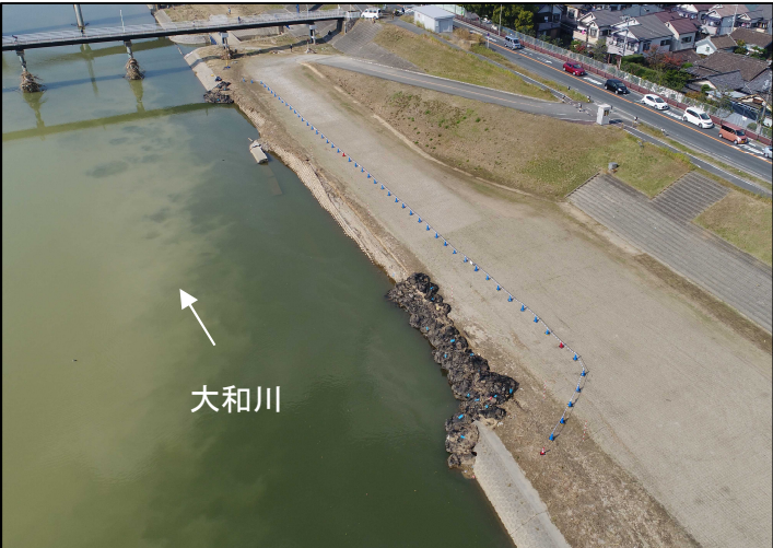
大和川右岸1.8k 低水護岸損壊 L=115m
