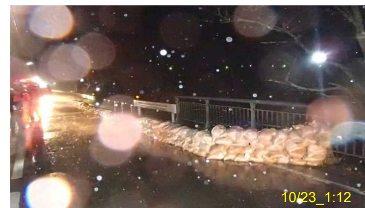
<積み土のう工完了>
