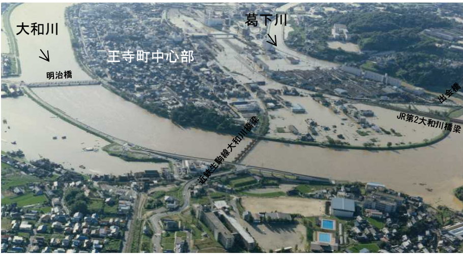
◀ 葛下川から溢水し、王寺町中心部が浸水
