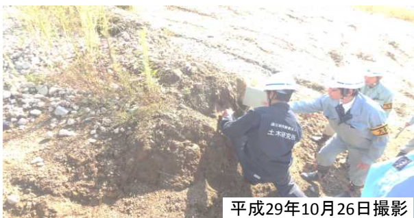
盛土(上部)の亀裂調査
