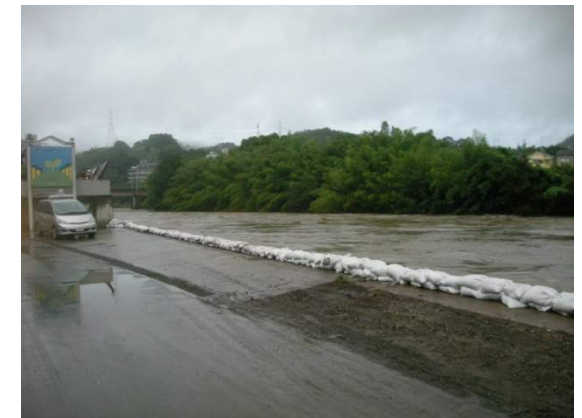
土のう積み完了
