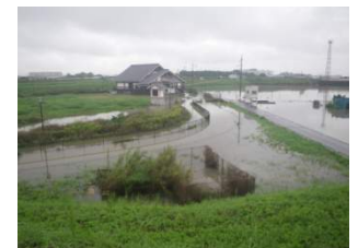
⑥ 浄化施設付近 (16時半頃)
