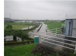
⑤ 浄化施設付近 (16時半頃)
