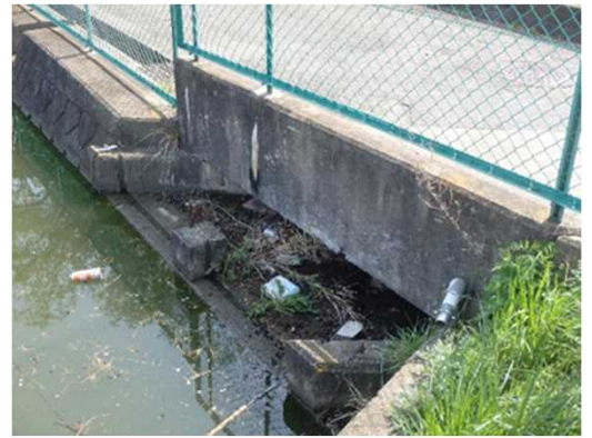
余水吐（着手前）
