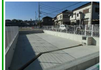
工事中の地下貯留施設 (田原本町)
