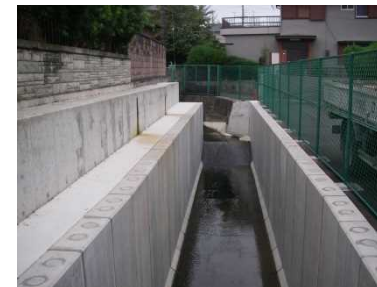
雨水幹線整備後
