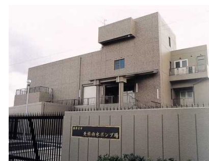
北條雨水ポンプ場
