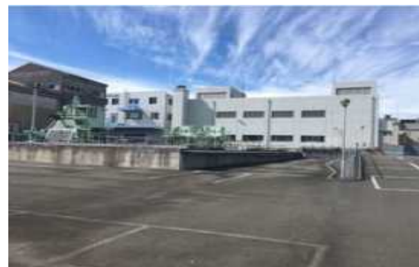
片山雨水ポンプ場
