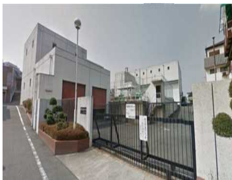
国分第2雨水ポンプ場
