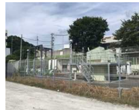
国分市場第1雨水ポンプ場
