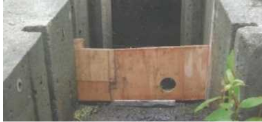
調整板の設置例 (大和郡山市)
