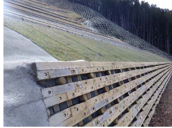
R2.3_山腹工施工状況：天川区域 坪内（天川村）
