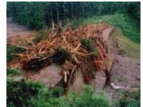
流木捕捉式治山ダム
