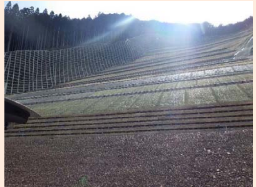
▲【R2.3完成 天川区域 坪内】
