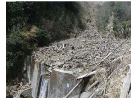
治山ダムが山腹崩壊と土砂流出を軽減した事例【大分県日田市】
