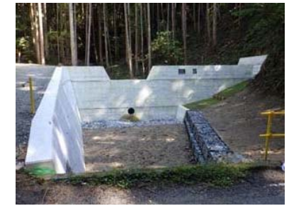
【治山：溪間工（治山ダム）】
