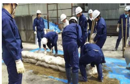
土のう積み様子
