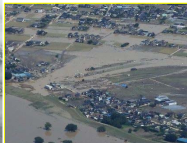
破堤箇所の拡大
