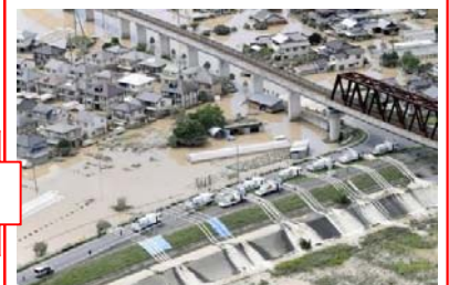
遠方の地整から支援のあった平成30年西日本豪雨時の排水作業状況を反映
