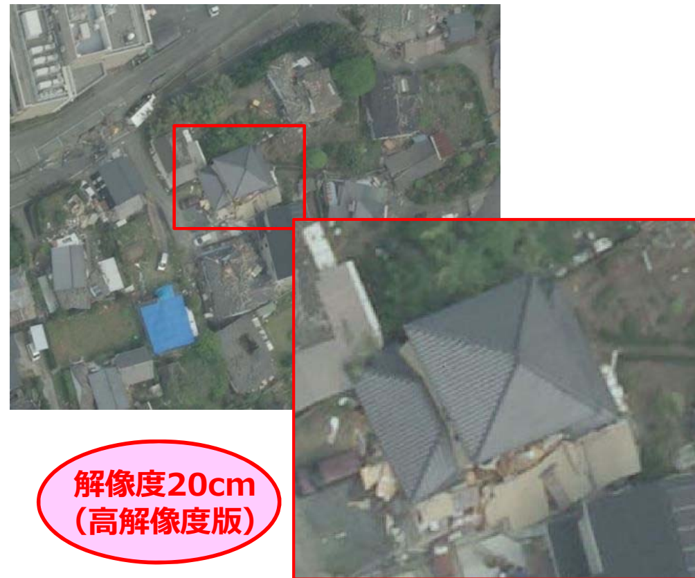
平成28年熊本地震（益城町役場周辺）
