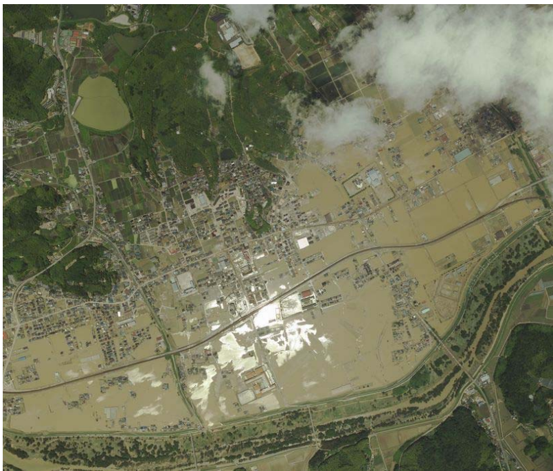
平成30年7月豪雨（倉敷市真備町付近）
