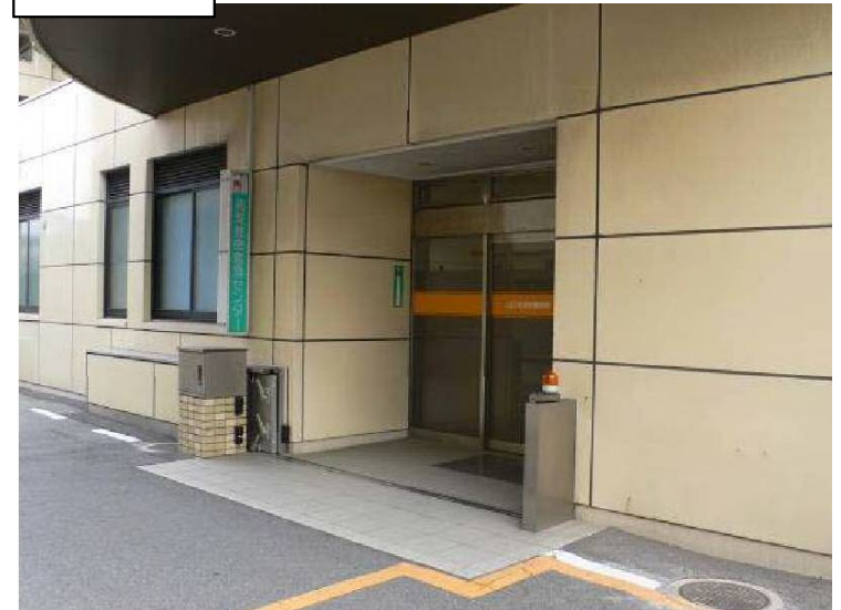
止水板の設置(病院)
