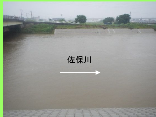
出水時(佐保川旧長安寺井堰周辺)
