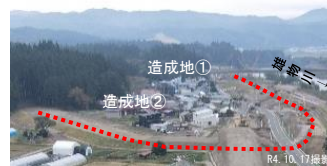
移転家屋の建設が進む状況
