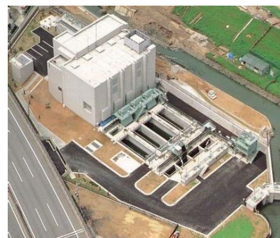
小山雨水ポンプ場
