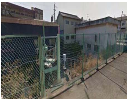
国分第1雨水ポンプ場
