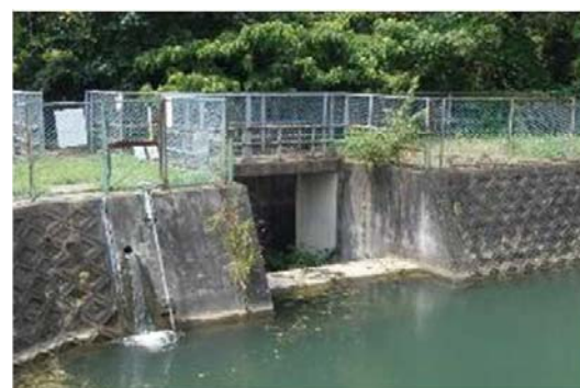
余水吐（着手前）
