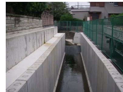
雨水幹線整備後
