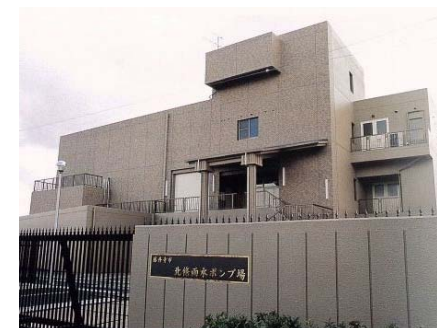
北條雨水ポンプ場
