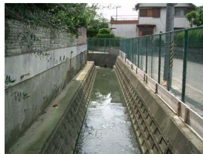
雨水幹線整備前の状況
