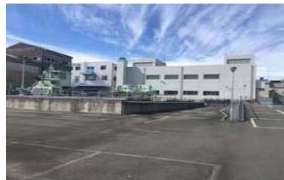
片山雨水ポンプ場
