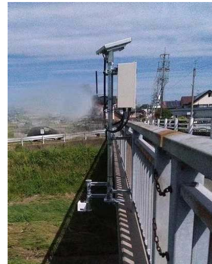
危機管理型水位計(超音波式) (設置例)
