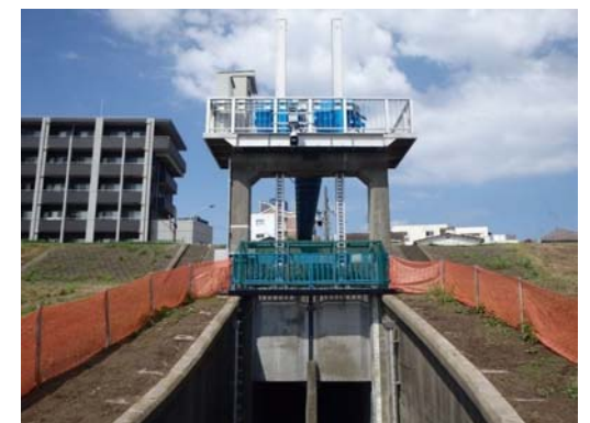
<樋管ゲート写真>
