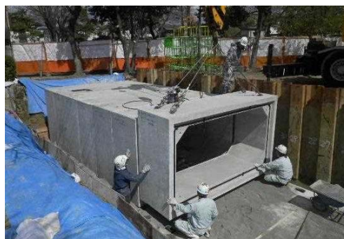
校庭の地下への雨水貯留槽の設置
