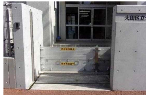
通用門に設置した止水板
