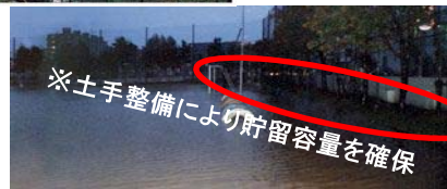
【校庭を活用した貯留施設】
