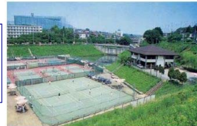
雨水貯留浸透施設の例(防災調整池)
