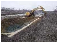
河道掘削 (石狩川水系、北海道開発局)
