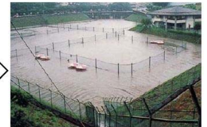
雨水貯留浸透施設の例(防災調整池)
