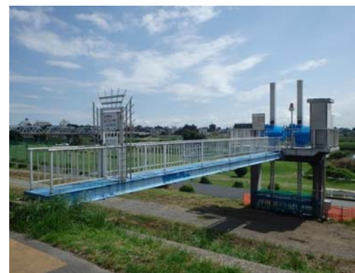
<樋管全景写真>
