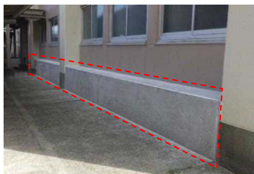
構造体の補強による対策後
