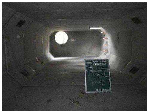
雨水貯留槽の内部
