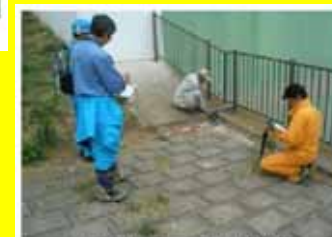
護岸陥没の測定状況
