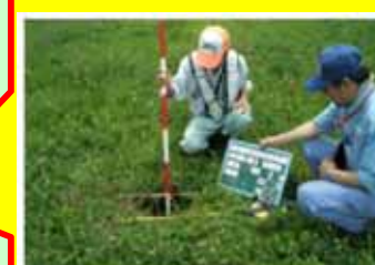
堤防陥没箇所の測定状況
