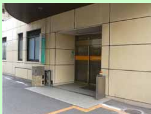
止水板の設置(病院)
