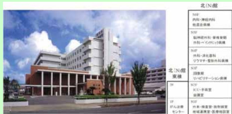
電気設備MRI等の2階設置(病院)
