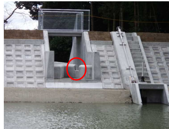
葛城市 大屋下池
