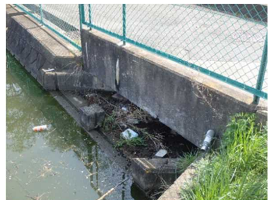
余水吐（着手前）
