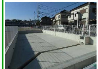
工事中の地下貯留施設 (田原本町)
