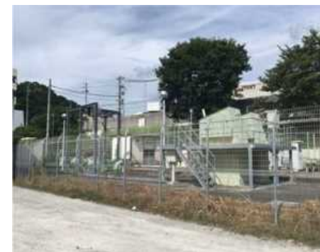
国分市場第1雨水ポンプ場
