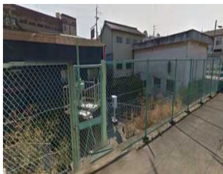
国分第1雨水ポンプ場
