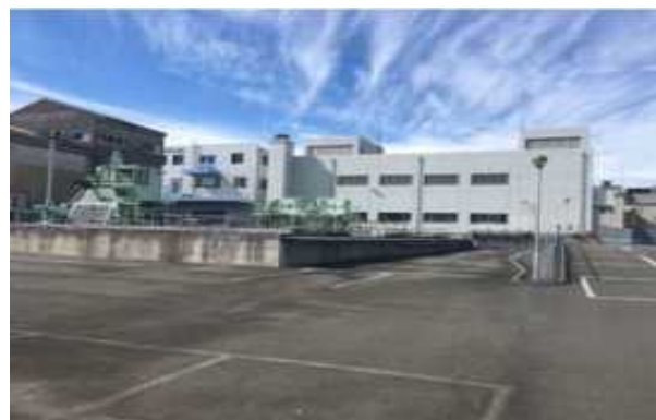
片山雨水ポンプ場
