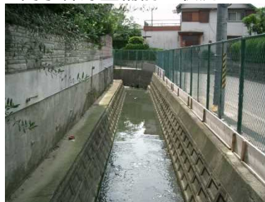
雨水幹線整備前の状況
