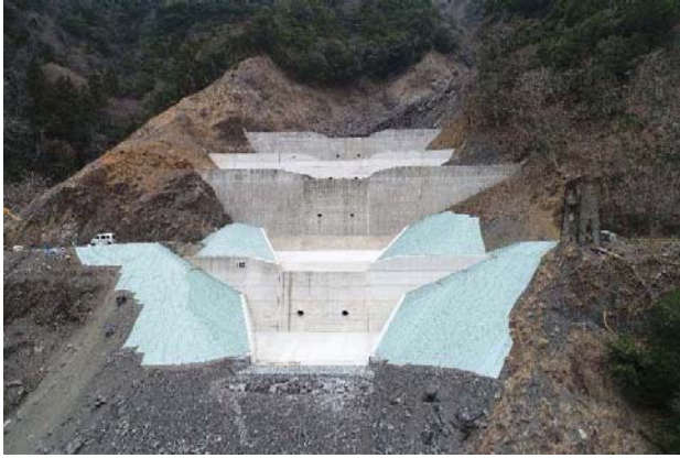
R2.3_谷止工施工状況：宇宮原区域 濁谷（十津川村）
