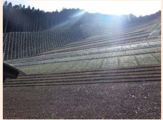
▲【R2.3完成 天川区域 坪内】
