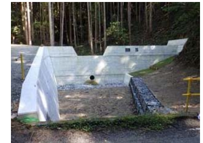
【治山：溪間工(治山ダム)】
