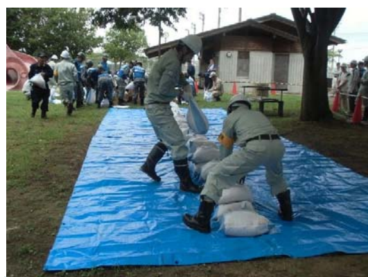
積み土のう設置
