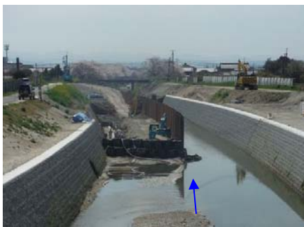
高田川(護岸改修工事)
