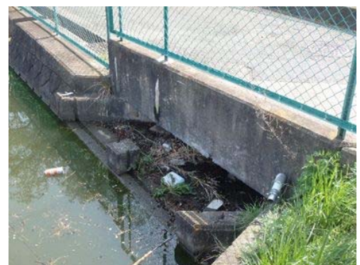
余水吐（着手前）
