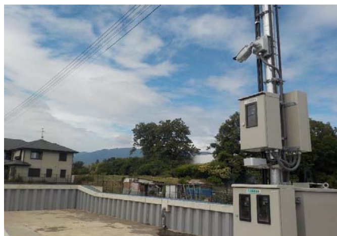
③池田貯留施設
