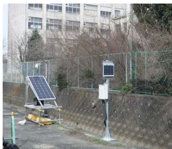
設置状況（水位計・太陽光パネル）
