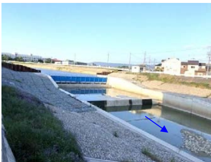
富雄川(井堰改修工事)
