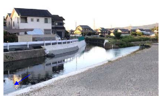
地藏院川(護岸改修工事)
