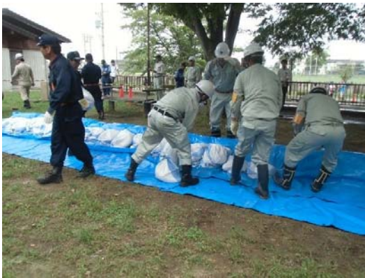
積み土のう設置
