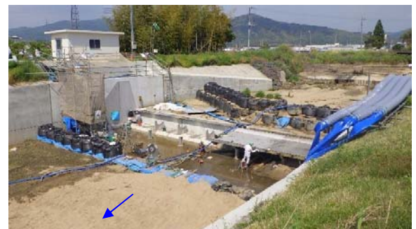
寺川(井堰改修工事)
