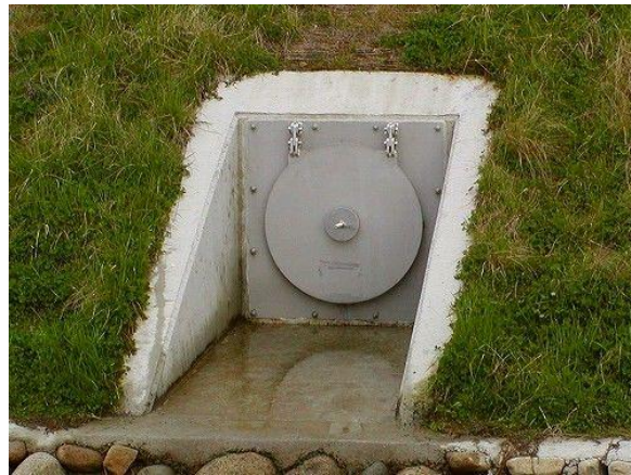
樋管ゲートの無動力化 (フラップゲートの設置例: NETIS新技術情報提供システム) http://www.netis.mlit.go.jp/NetisRev/Explanation/MainExplanation.asp
