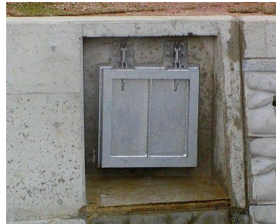
樋管ゲートの無動力化 (フラップゲートの設置例: NETIS新技術情報提供システム) http://www.netis.mlit.go.jp/NetisRev/Explanation/MainExplanation.asp
