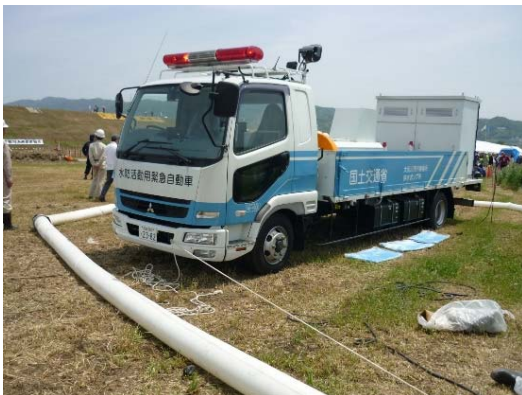
排水ポンプ車による排水
