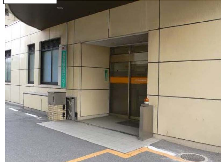
止水板の設置(病院)
