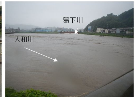
出水時 (大和川27.0k付近)
