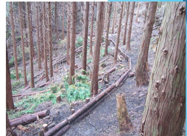
(間伐木を利用した丸太筋工)
