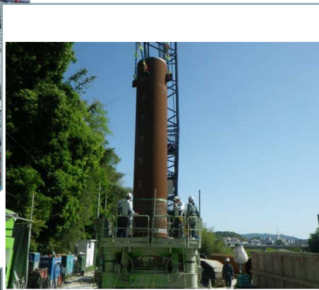
鋼管杭打設状況
