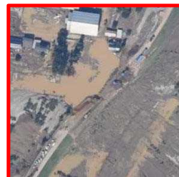
堤防決壊 付近を拡大
