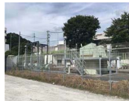
国分市場第1雨水ポンプ場
