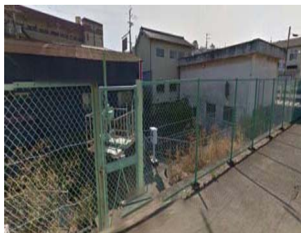
国分第1雨水ポンプ場
