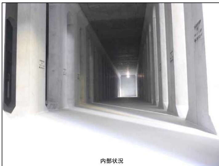
①社会福祉協議会駐車場地下貯留施設 (貯留量 3,873m 3 )
