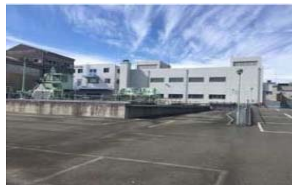
片山雨水ポンプ場
