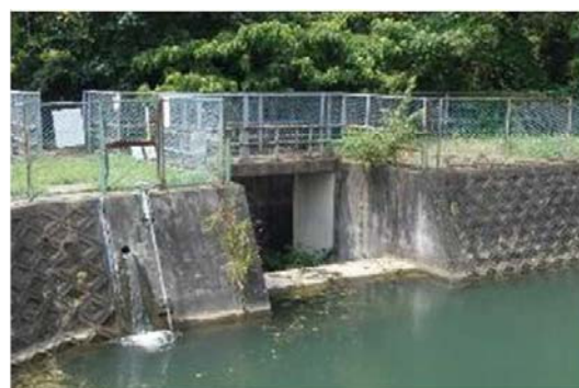
余水吐（着手前）
