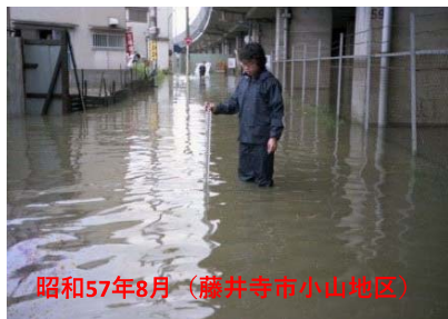
浸水対策前の浸水状況
