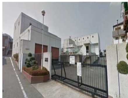
国分第2雨水ポンプ場
