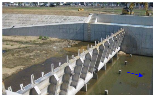
寺川(井堰改修工事)
