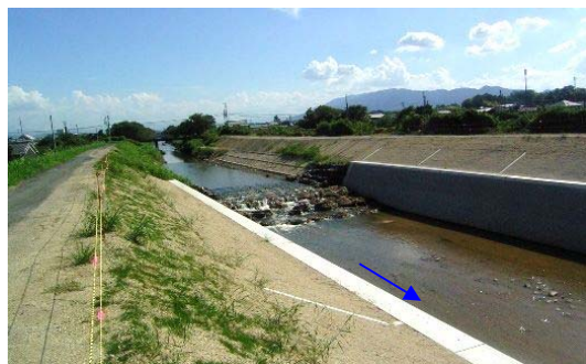
高田川(護岸改修工事)
