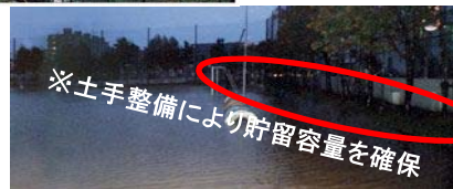
【校庭を活用した貯留施設】
