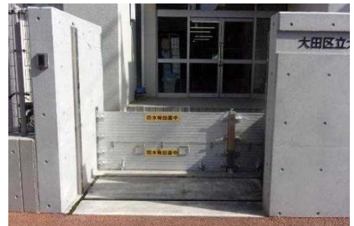
通用門に設置した止水板
