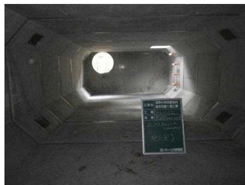
雨水貯留槽の内部
