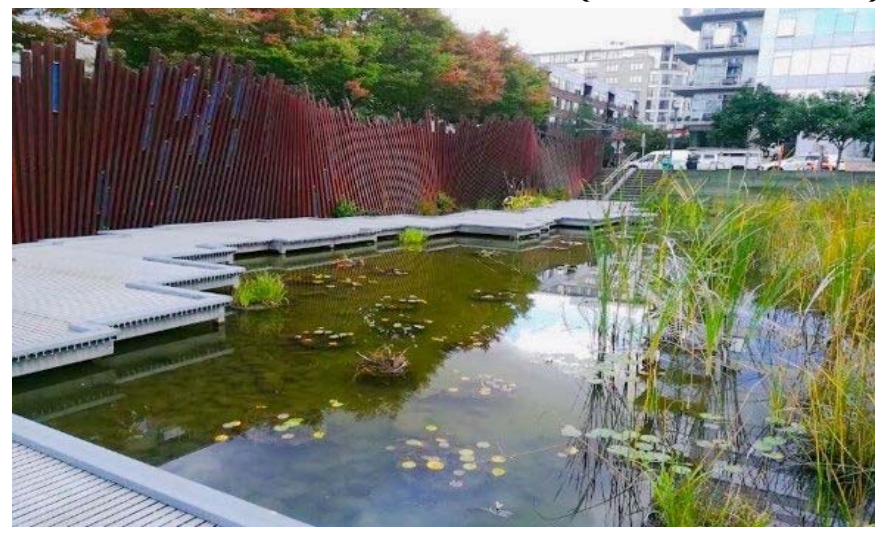
緑地を周辺敷地よりも約1.8m下げて整備することで、雨水貯留機能を持たせている。
