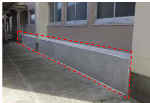
構造体の補強による対策後
