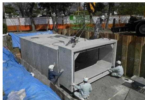
校庭の地下への雨水貯留槽の設置
