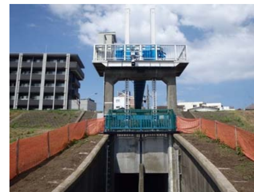
<樋管ゲート写真>
