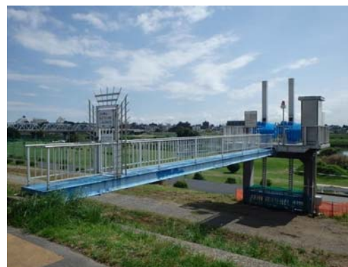
<樋管全景写真>
