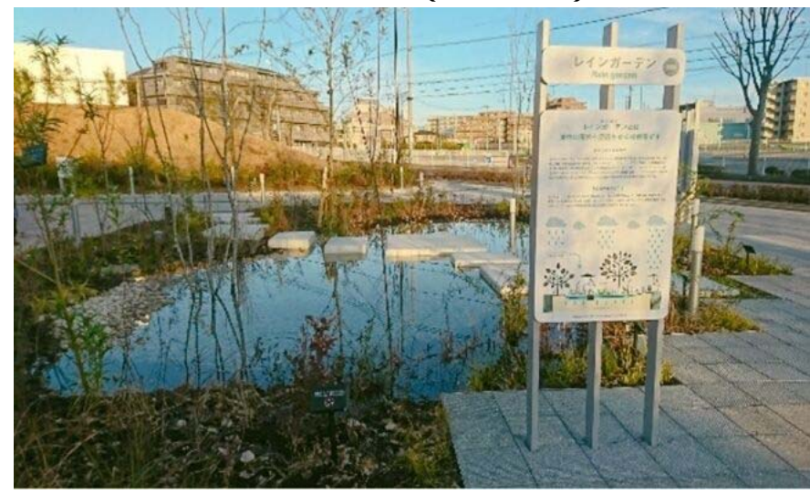
グランベリーパーク地区全体で、緑地等の有する雨水貯留浸透機能を生かしたまちづくりが行われており、その一環としてレインガーデンが整備されている。
