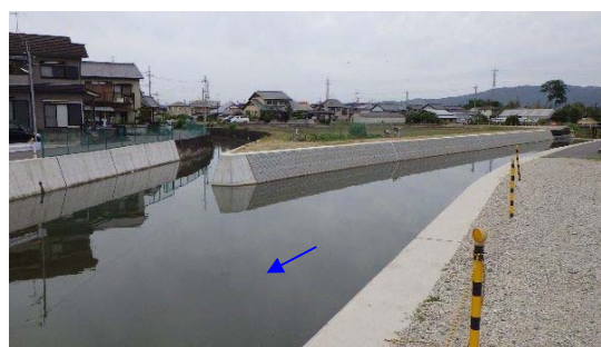
地藏院川(護岸改修工事)
