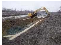
河道掘削 (石狩川水系、北海道開発局)
