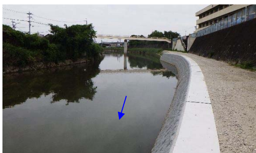
竜田川(護岸改修工事)
