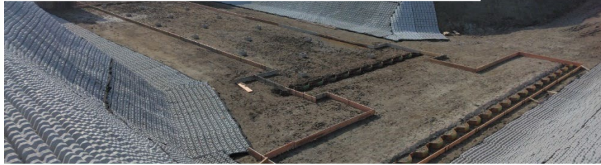
均しコンクリート型枠組立完了（1月22日時点）
