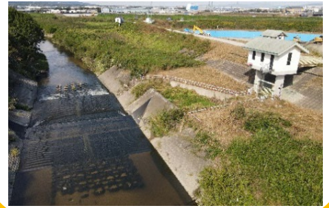
曾我川樋門（現況）
