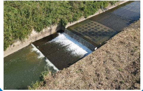
飛鳥川魚道ブロック設置エリア
