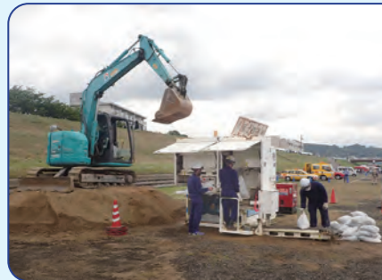
土のうを製作する
