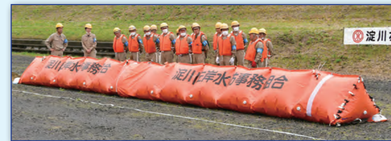
② 給水口から水を注入 ※訓練のため代わりに空気を入れる
