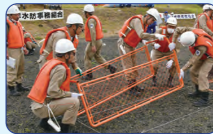
① 鋼製の枠を設置する
