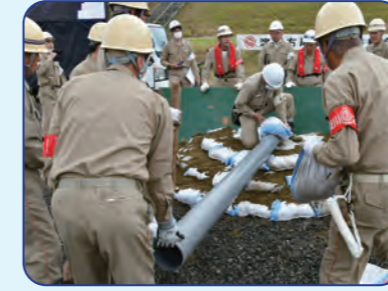
④ 排水パイプを取り付ける
