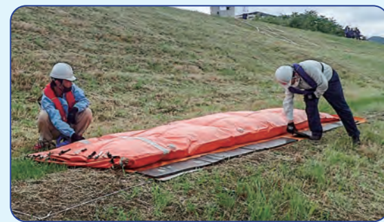
給水口から水を注入 ※訓練のため代わりに空気を入れる
