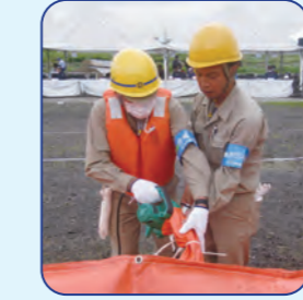
② 給水口から水を注入 ※訓練のため代わりに空気を入れる
