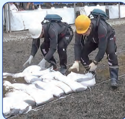
② 地面に土を敷いて、土のうを並べる
