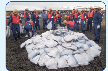
③ 固めた間詰め土の上に土のうを積み上げる
