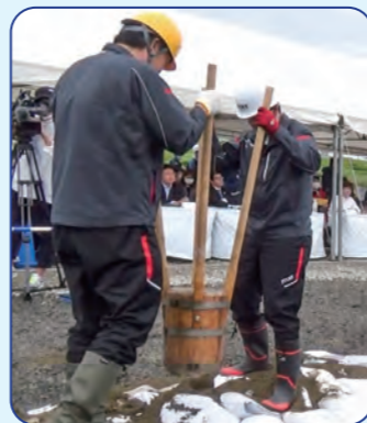
③ 周詰め土を敷いて、タコ楯で固める
