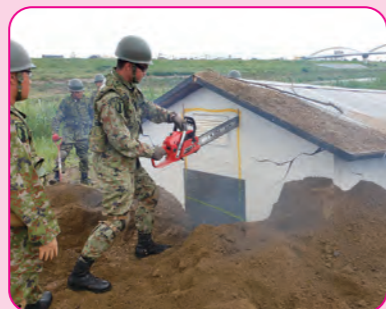
② エンジンカッターで壁面を開放する
