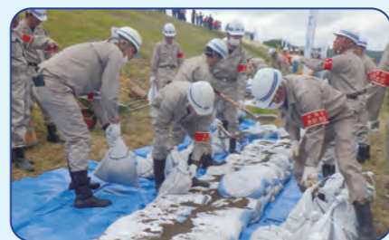
② シートを敷いて、土のうを並べる
