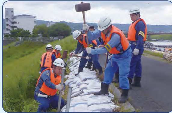
① 堤内側に固定用の杭を打ち込む
