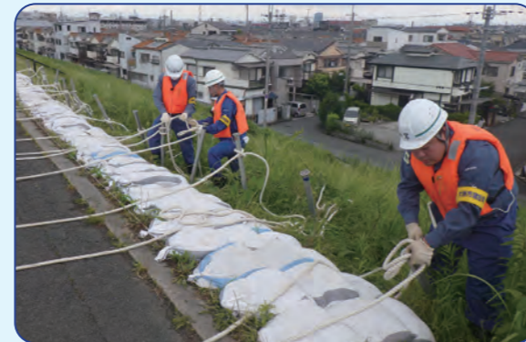
④ 固定用の杭にロープを結束する
