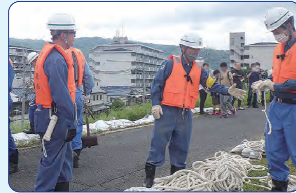
② 作業員の安全確保 (命綱)
