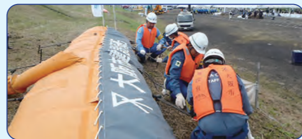
② 固定用の杭を打つ
