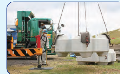
根固めブロック設置の様子
