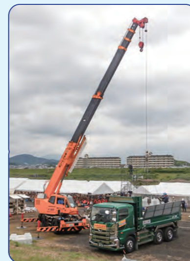
クレーンで根固めブロック吊り上げ
