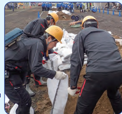
① 土のうをつくる
