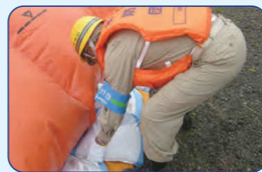
④ 押え土のうを設置する
