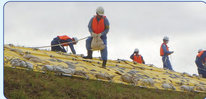
⑤ 土のうで斜面にシートを固定する
