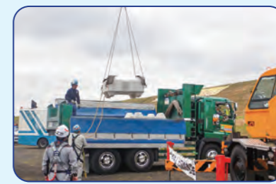
クレーンで根固めブロック吊り上げ
