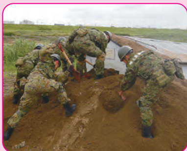
① 家屋周辺の土砂やがれきを撤去する
