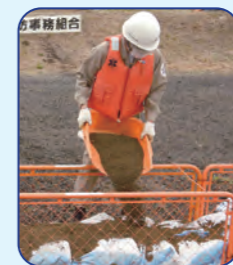
③ 間詰め土を敷く
