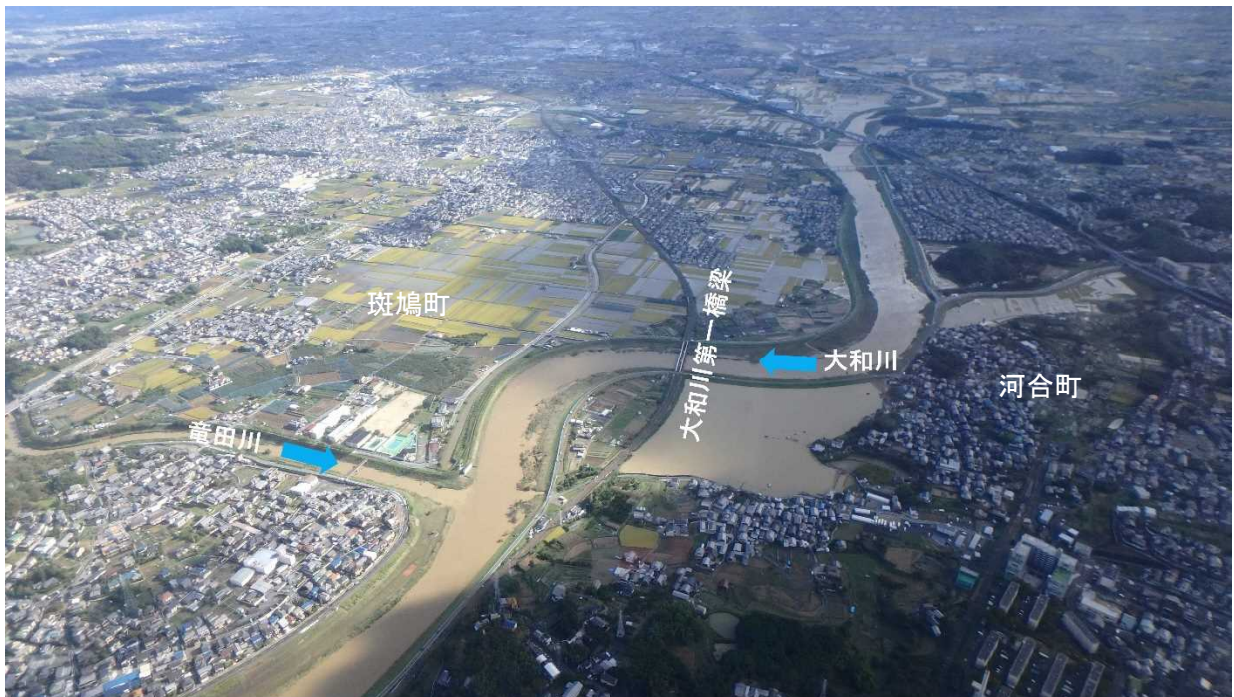
写真 1-4 平成 29 年 10 月洪水浸水状況（斑鳩町・河合町付近）
