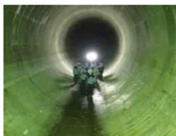
雨水貯留管の整備
