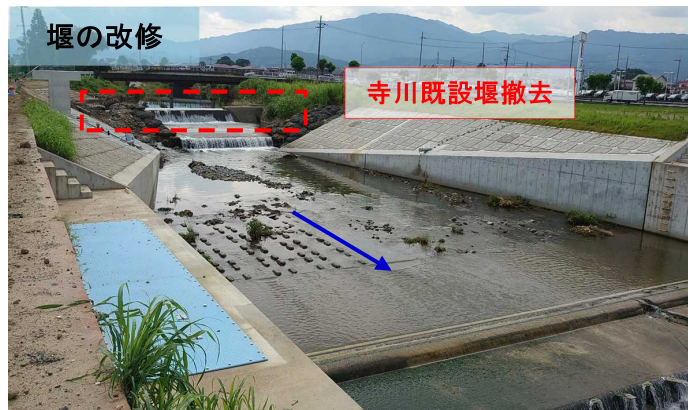
図 4-5 桜井市大福工区佛生井堰（寺川）
