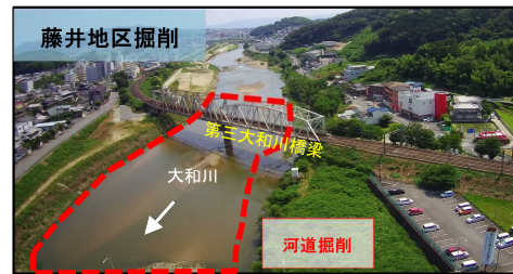
図 2-3 藤井地区掘削
