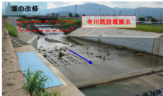
図 4-5 奈良県桜井市大福工区佛生井堰（寺川）
