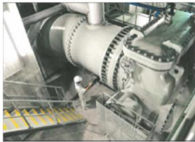
雨水ポンプの整備
