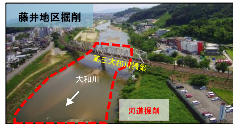
図 2-3 藤井地区掘削
