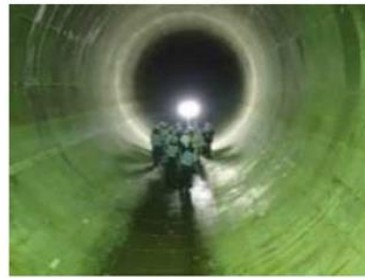
雨水貯留管の整備
