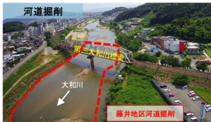
図 4-3 藤井地区河道掘削
