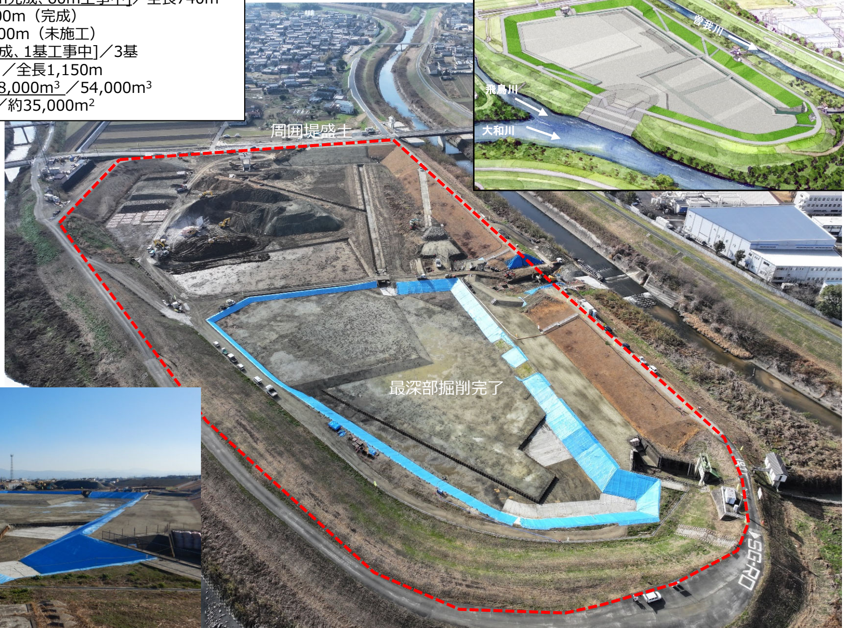
遊水地底面部掘削完了
