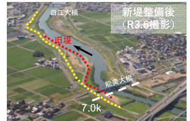
引堤(石川県梯川水系梯川)
