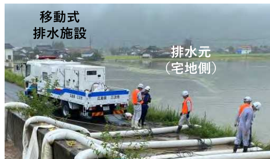
樋管のゲートにポンプを設置
