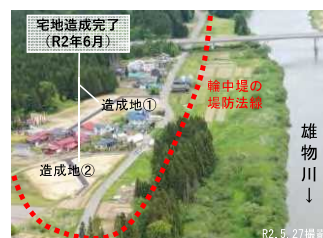
移転先宅地造成完了状況
