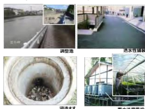
雨水貯留浸透施設の実例
