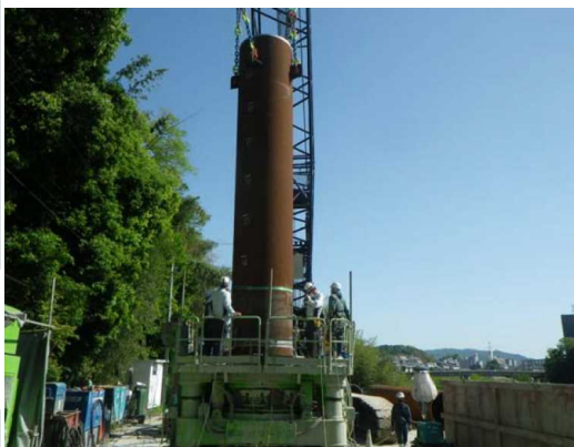
鋼管杭打設状況
