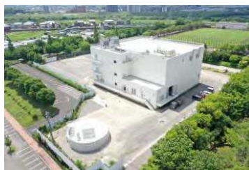
雨水ポンプ場
