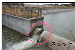
▲スリットの設置状況
