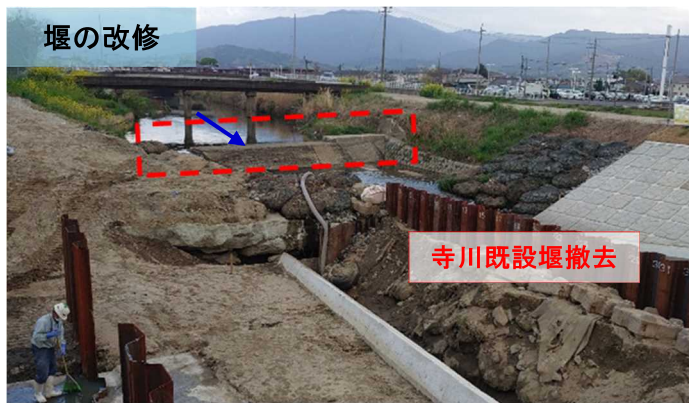
図 4-5 奈良県桜井市大福工区佛生井堰（寺川）
