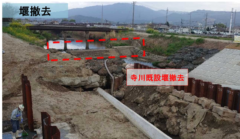
奈良県桜井市大福工区佛生井堰
