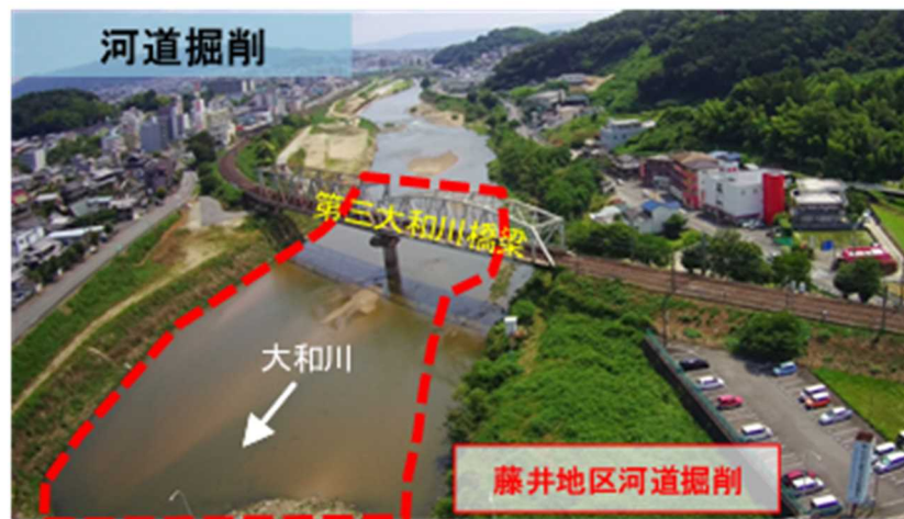
奈良県藤井地区第三大和川橋梁
