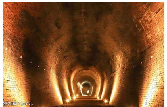
旧大阪鉄道亀瀬隧道（亀の瀬排水トンネル内）
