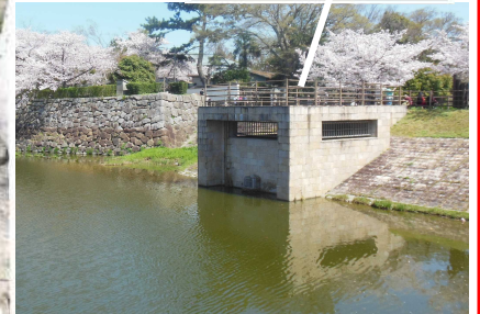
ため池の治水利用（大和郡山市鯉堀池）
