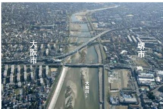
阪神高速大阪堺線橋梁付近
