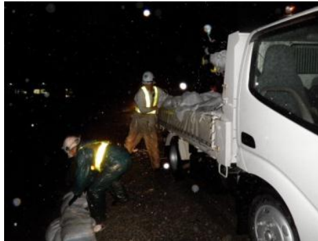
積み土のうによる水防活動支援
