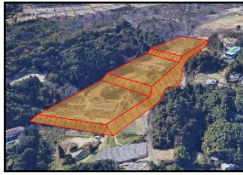
(三郷町)掘削土を利用した広域防災拠点整備
