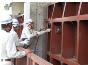
河川構造物の点検
