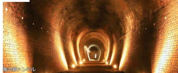
旧大阪鉄道亀瀬隧道
