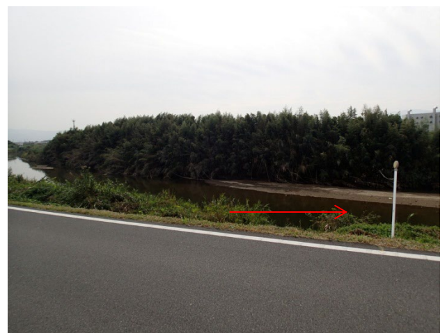
図 1.3.6 樹木の繁茂状況（大和川左岸 33.6k）
