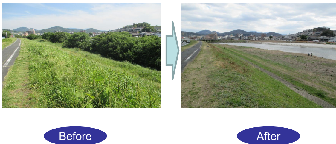
図 1.3.8 流下阻害の懸念がある河道内樹木の伐採状況 (柏原市河川敷緑地公園周辺)
