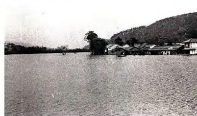
大和川上流部の浸水
