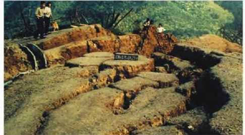
畑地の亀裂・陥没
