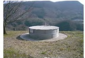
集水井地上部
