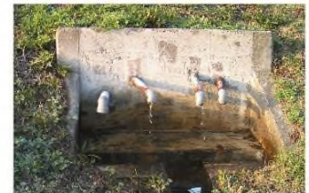
横ボーリング
