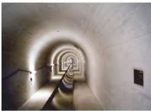
排水トンネル内部
