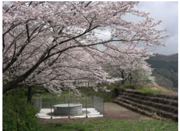
植樹された桜と集水井
